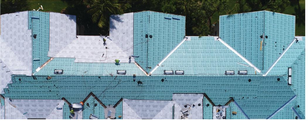
Polystick MTS PLUS se puede utilizar como una capa base individual de alta temperatura o como una capa base en un sistema de dos capas para una garantía de hasta 30 años.
